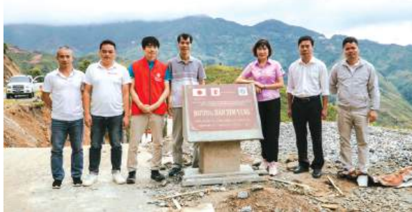
Nghiệm thu, bàn giao công trình đường giao thông bản Xím Vàng, xã Xím Vàng
